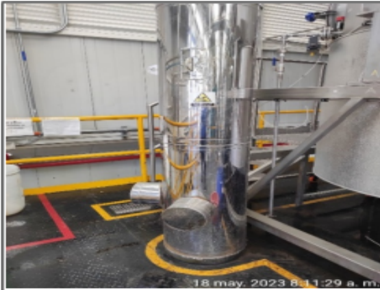
Fotografía 7. Puertos y plataforma de muestreo Caldera Bosch
